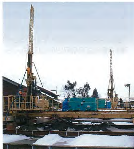
写真-7 台車走行式の移動装置と施工機
