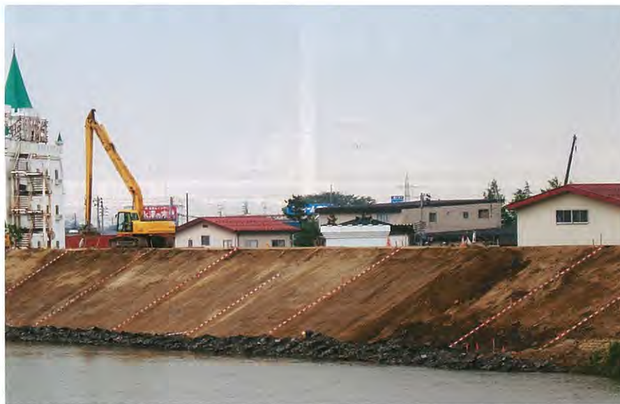
写真-9 復旧された堤防
