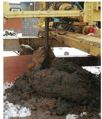
写真-8 排土状況
