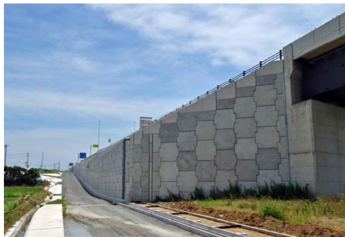
工事竣工写真
